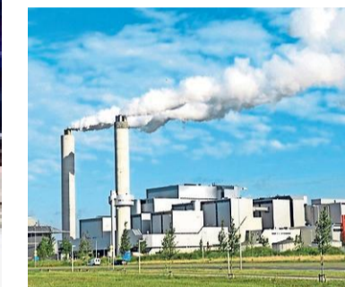
De energiecentrale van het Afval Energie Bedrijf Amsterdam.
