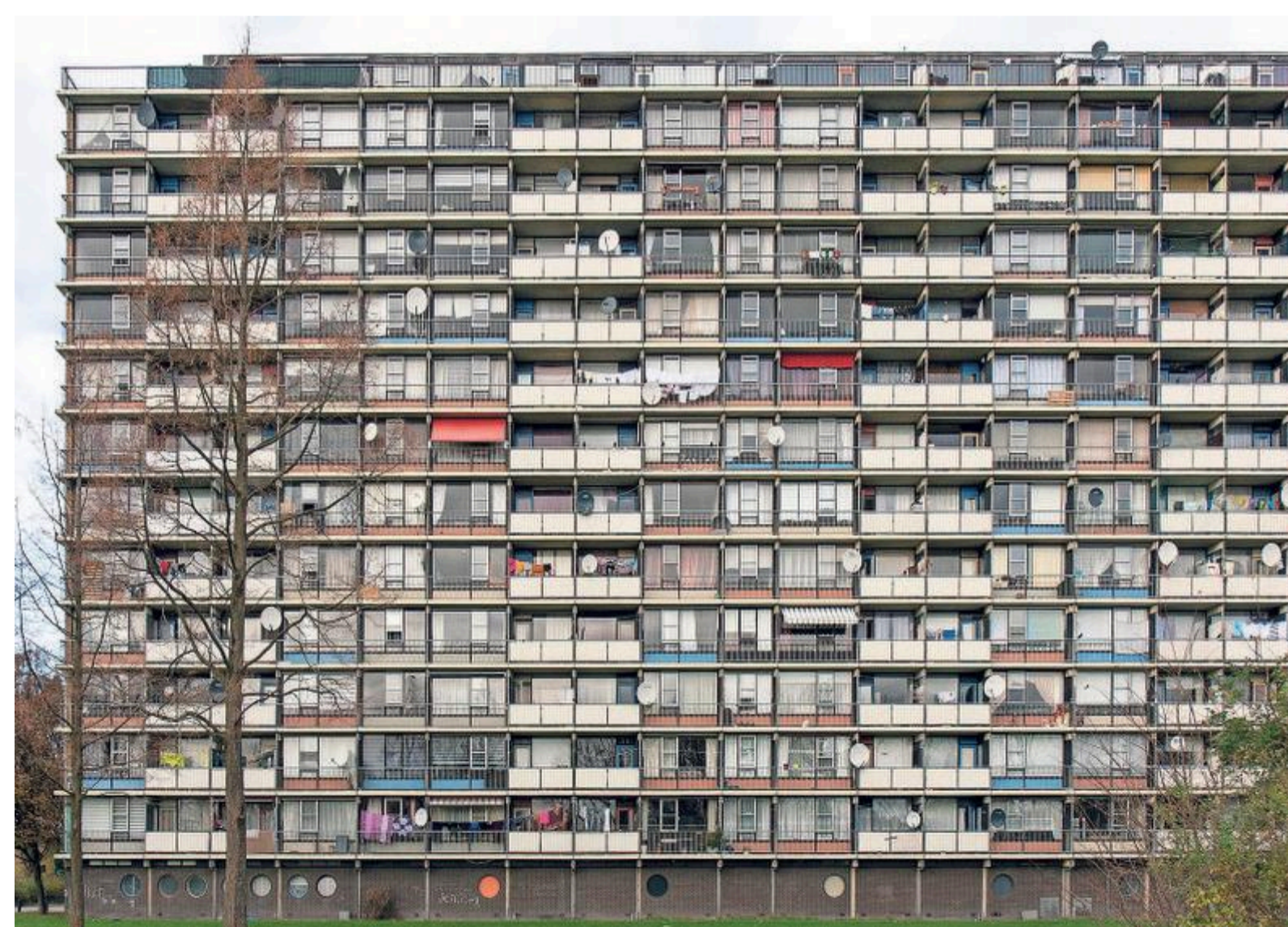
De Indigoflat nu: geverfd in vier verschillende kleuren, met dichte schotten op de balkons en hier en daar schotelantennes.
