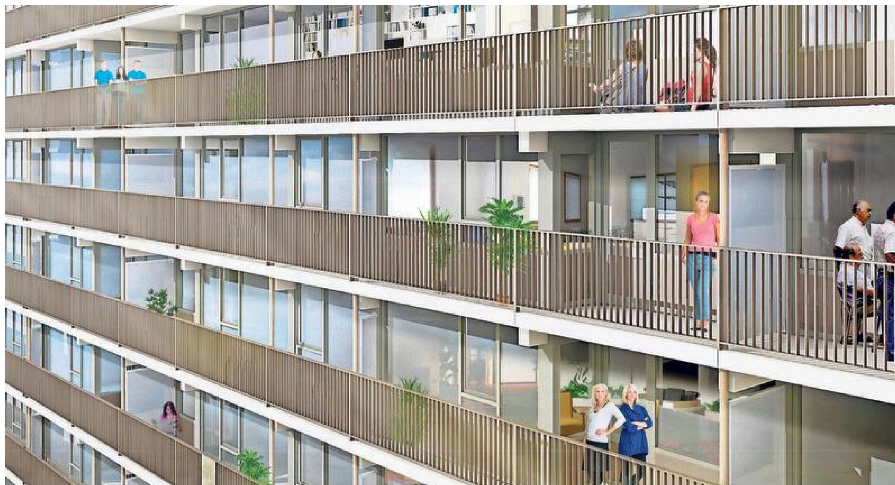
De Indigoflat krijgt straks een strakke, transparante uitstraling. De dichte schotten op de balkons verdwijnen. Voor schotelantennes gaan waarschijnlijk strengere regels gelden.
